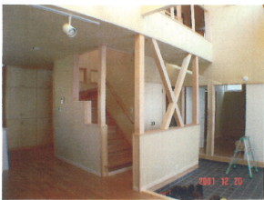
階段・内土間・吹抜
